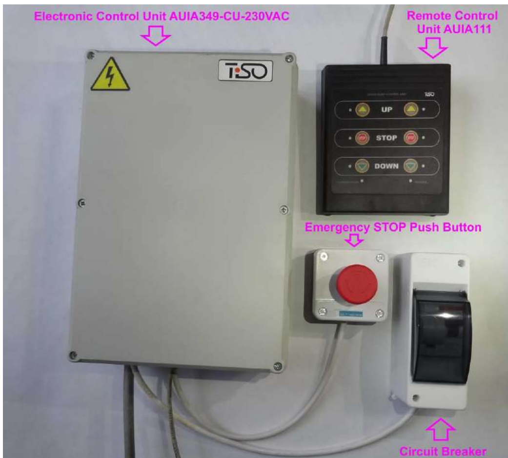
Рис. 6. Блок управления блокираторами RB349-CU-230VAC с пультом дистанционного управления AUJA111 , кнопкой аварийной остановки и выключателем питания.
